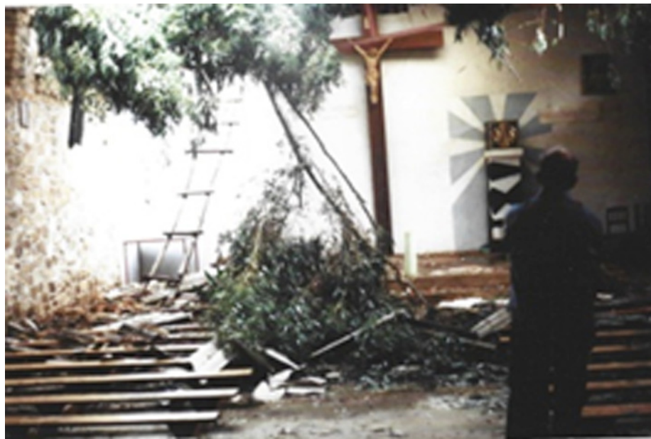
Kościół zniszczony przez wojnę
