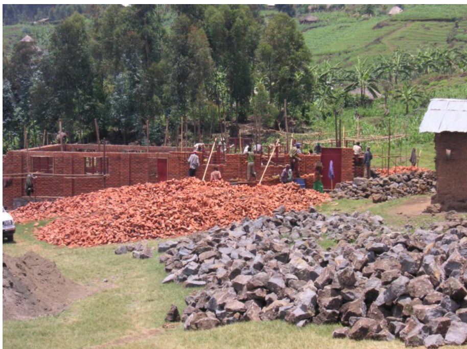
Budowa szkoły. Ze względu na teren wulkaniczny i częste trzęsienia ziemi, konieczne jest zastosowanie specjalnych zabezpieczeń i umocnień konstrukcji za pomocą prętów stalowych
