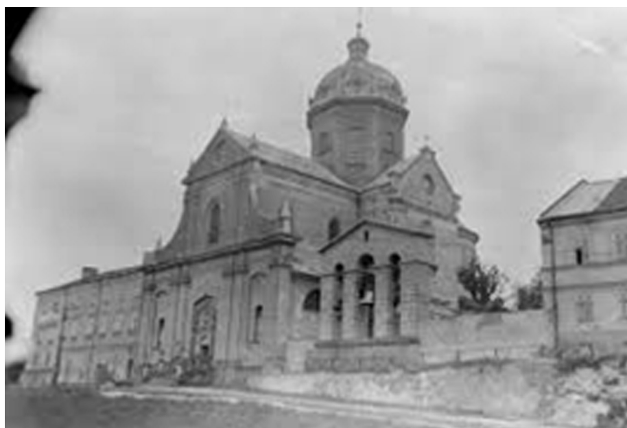
Drewniana atrapa kopuły, która do połowy lat 90-tych była elementem dachu
